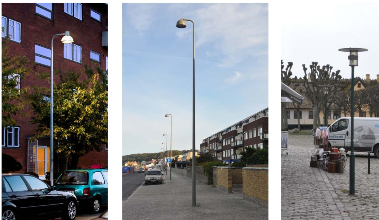
Figur 4: Eksempler på armaturer og master der vha. indfarvning har et tilpasset og æstetisk udtryk. De to vejarmaturer til venstre har en høj energieffektivitet, mens lygten til højre har en lavere effektivitet. Til venstre: ICON armatur, Frederiksberg Kommune. I midten: Københavnerarmatur, Helsingborg Strandpromenade. Til højre: Albertslund parklygte, Dragør Kommune.
